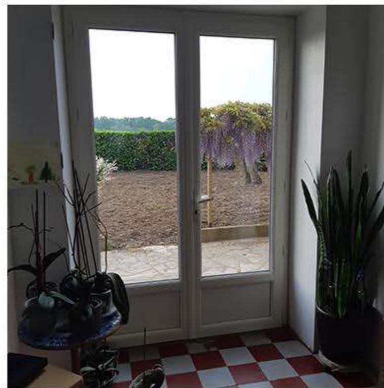
Porte centrale de la maison : elle est habituellement toujours fermée mais dû à une casse de la serrure de la porte d'entrée cette porte est devenue la nouvelle entrée de la maison. Ainsi cela modifie nos habitudes pour entrer et sortir de la maison.
